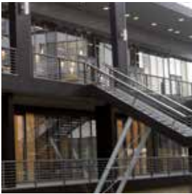
Menig & Partner, Rottendorf, (DE) Edificio de nueva obra S. Oliver Casino, (DE)
